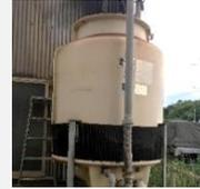
クーリングタワーは、水が蒸発する際に熱を奪う気化熱の原理を利用した冷却装置です。この原理を使って冷やした冷却水を円滑に循環させる必要があります。そのために補給すべき水量を把握し、運用できるよう取り組んでいます。
